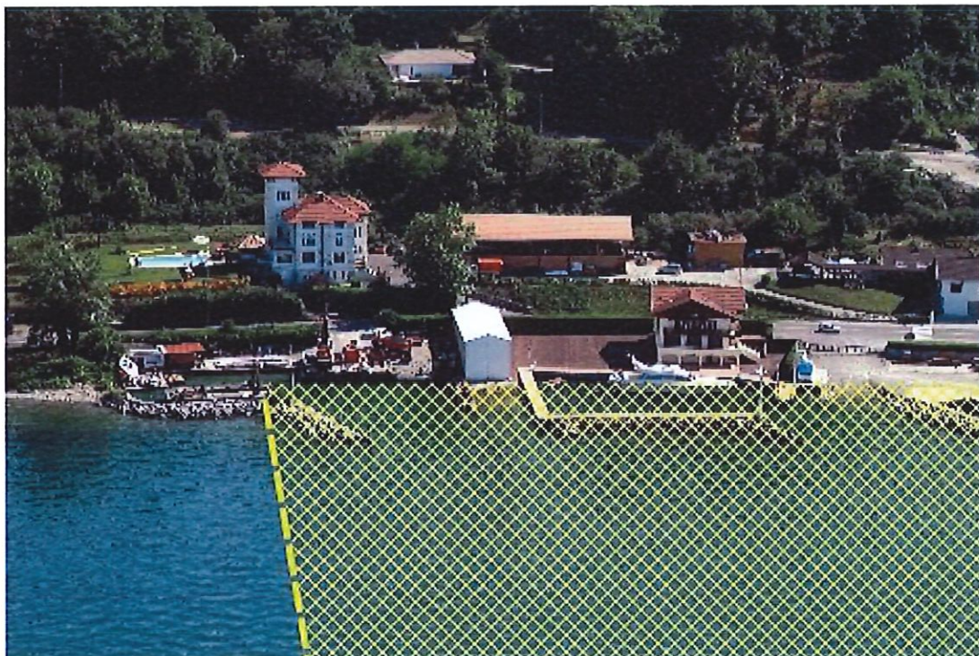
Photo 4 : limite zone restreinte est
